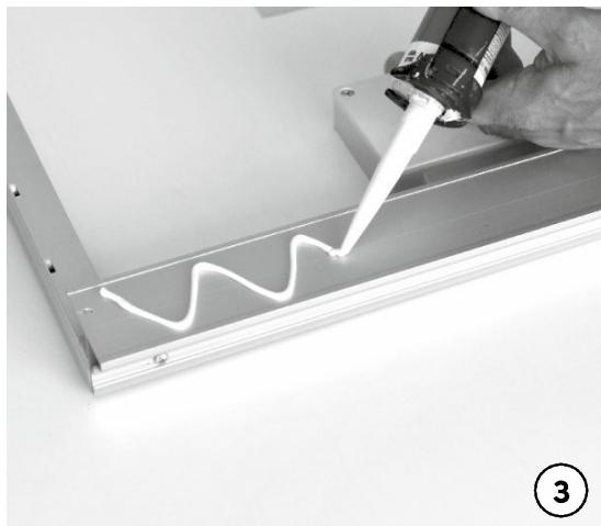
Den (wetterfesten) Polyurethanskleber auf den Befestigungsspoiler auftragen.
